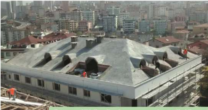
Beton dökümünden sonra her türlü malzeme ile su izolasyon kaplaması yapılabilir
