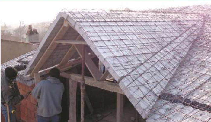
Zenon Panel ile muhtelif formlarda güvercinlik imalatı
