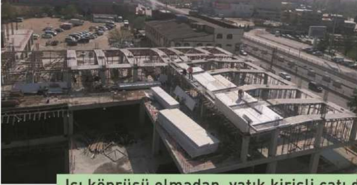
SKY Tower Projesi - Bursa
