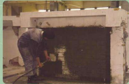
Zenon Panellerin sıvanması
