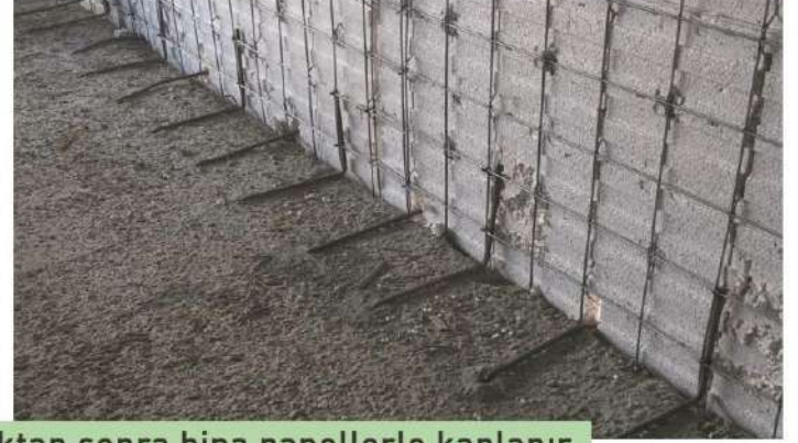
Betonarma karkas imalatı tamamlandıktan sonra bina panellerle kaplanır.
