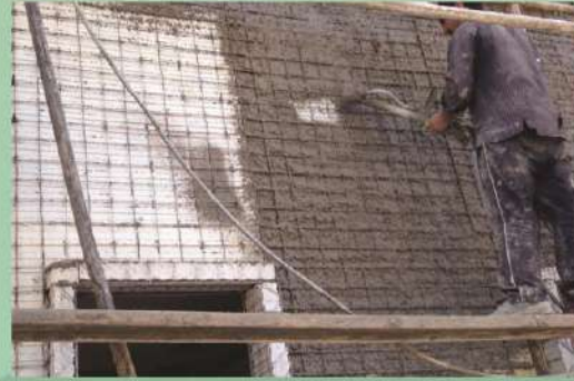
Püskürtme sıva makinesi ile sıva uygulaması
