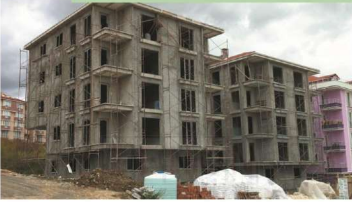
Betonarma karkas imalatı tamamlandıktan sonra bina panellerle kaplanır.
