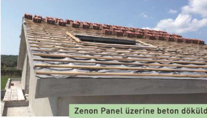
Beton dökümünden sonra her türlü malzeme ile su izolasyon kaplaması yapılabilir
