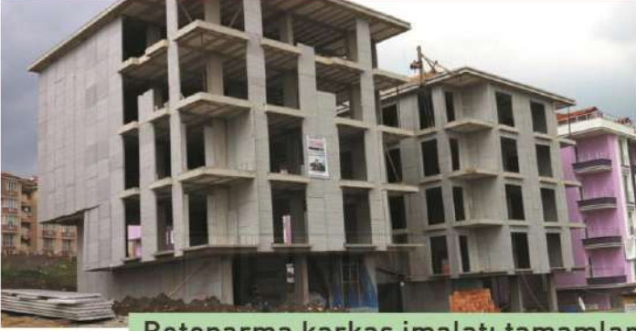
Betonarma karkas imalatı tamamlandıktan sonra bina panellerle kaplanır.
