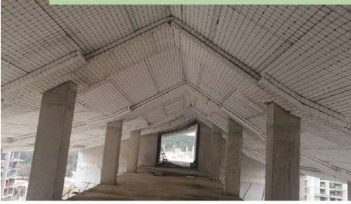
Yüksek ısı ve ses yalıtımlı, kalıcı çatı katları - betonarme esaslı hafif çatı çözümü
