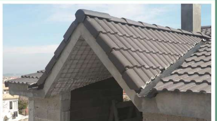
Zenon Panel ile muhtelif formlarda güvercinlik imalatı
